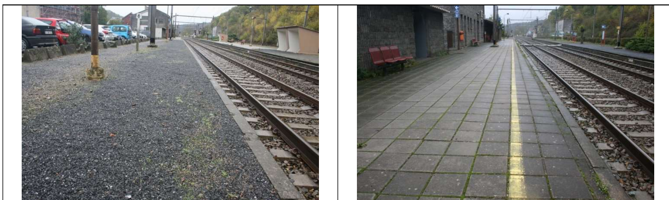
Revêtement des quais
