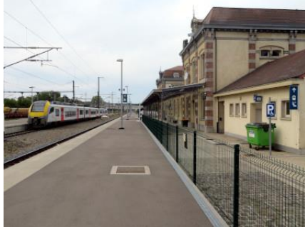
Vue intérieure de la gare avec le bâtiment à droite
