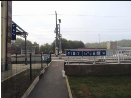
Signalétique au niveau de l'accès principal aux quais
