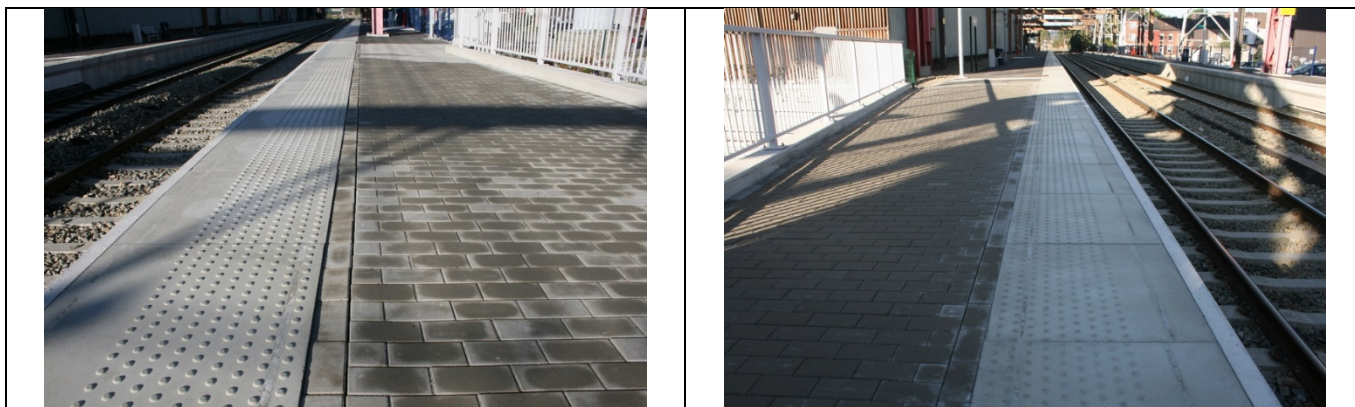
Revêtement des quais
