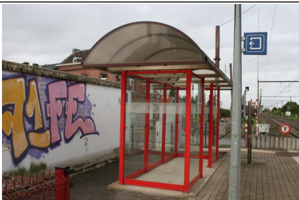
Abris sur les quais
