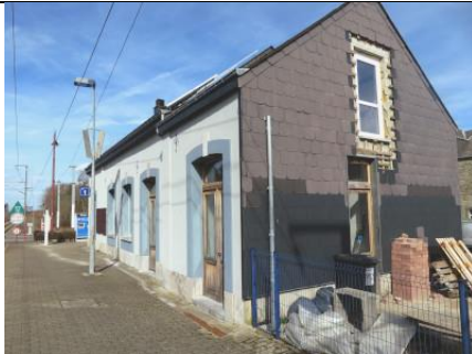
Ce qu'il reste de l'ancien bâtiment de gare, vu de la voie 1
