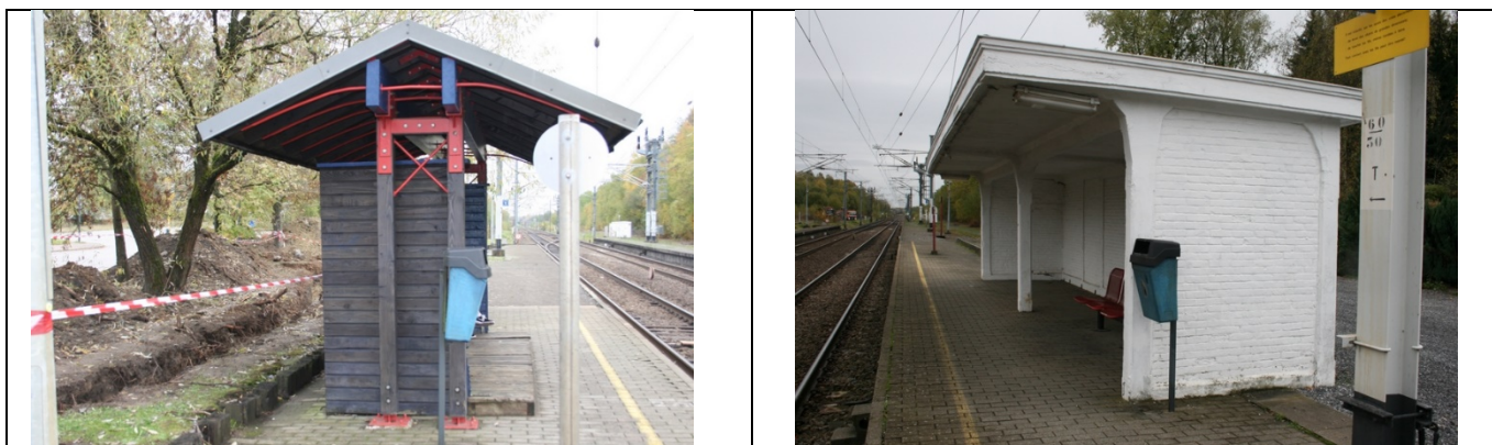
Abris sur les quais
