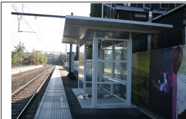
Abris sur les quais
