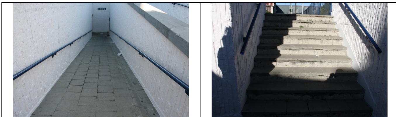
Accès au couloir sous-voies
