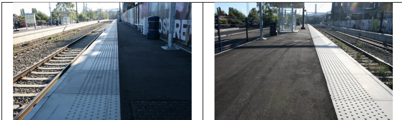
Revêtement des quais
