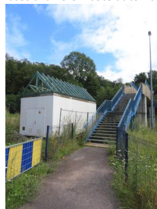
A l'approche de cette passerelle, à laquelle on accède via un long escalier
