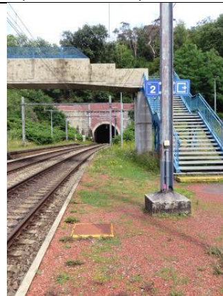
Indicateurs de quai et de sortie, à proximité de la passerelle
