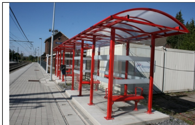
Abris sur les quais
