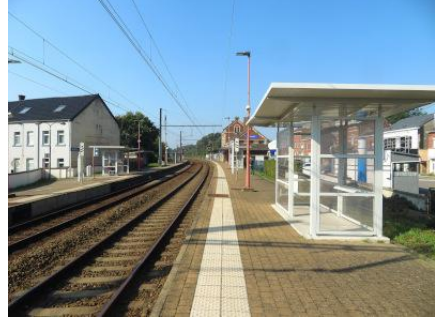
Vue d'ensemble prise du bout du quai 1 (côté Namur)
