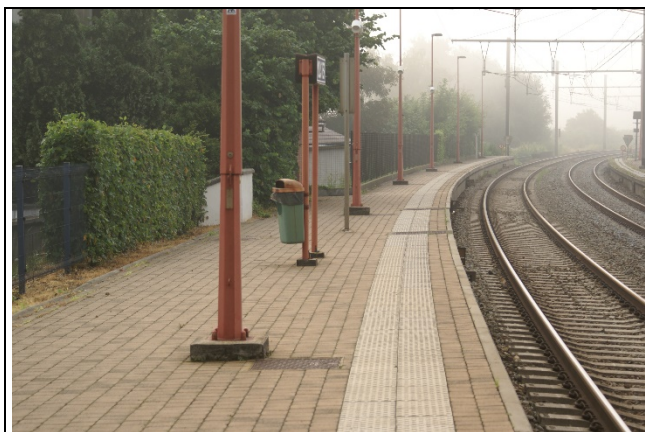
Revêtement des quais
