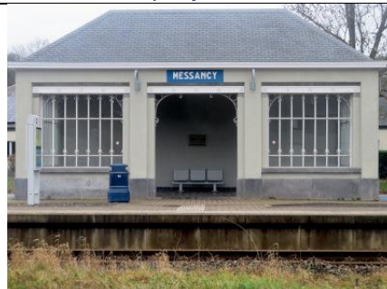
L'abri de quai joliment rénové
