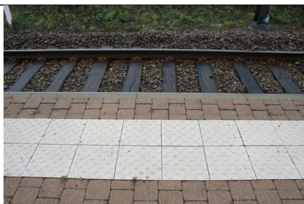
Présence de dalles podotactiles
