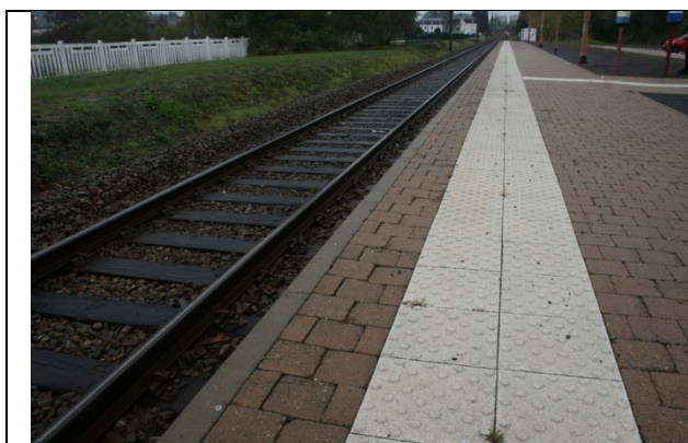
Revêtement des quais
