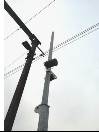
Eclairage LED, haut-parleur et mât pour une nouvelle horloge
