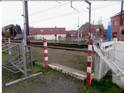
Accès au quai 1 à proximité du passage à niveau
