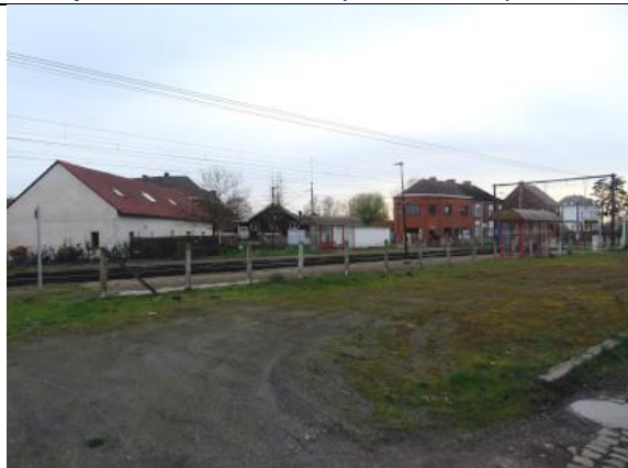
Le bâtiment de gare se tenait jadis sur la dalle à l'avant-plan. Aujourd'hui, les voitures y stationnent parfois.
