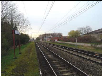
Vue des quais prise de l'extrémité du quai 2
