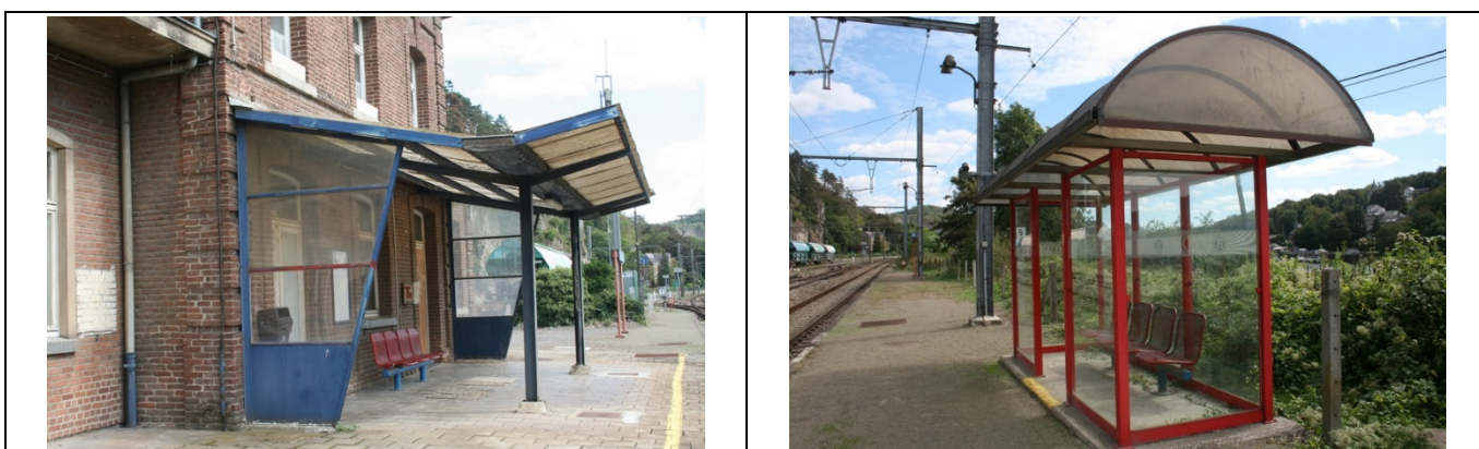
Quai partiellement couvert
