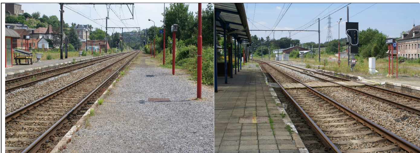
Revêtement des quais
