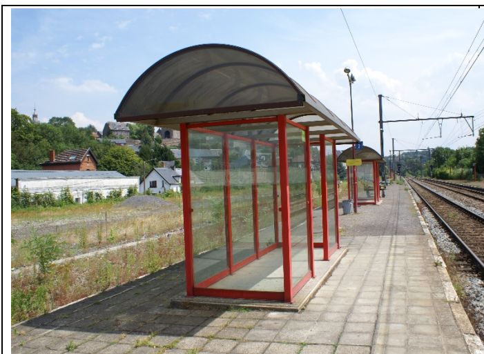
Abris sur les quais
