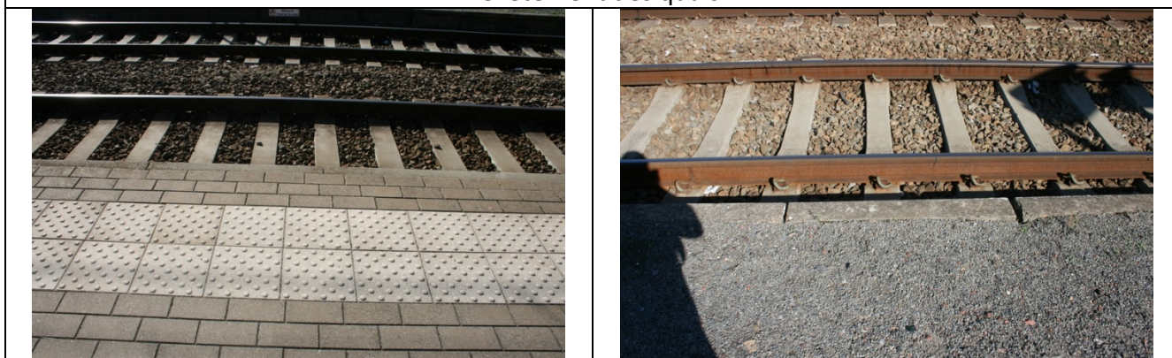
Présence de dalles podotactiles
