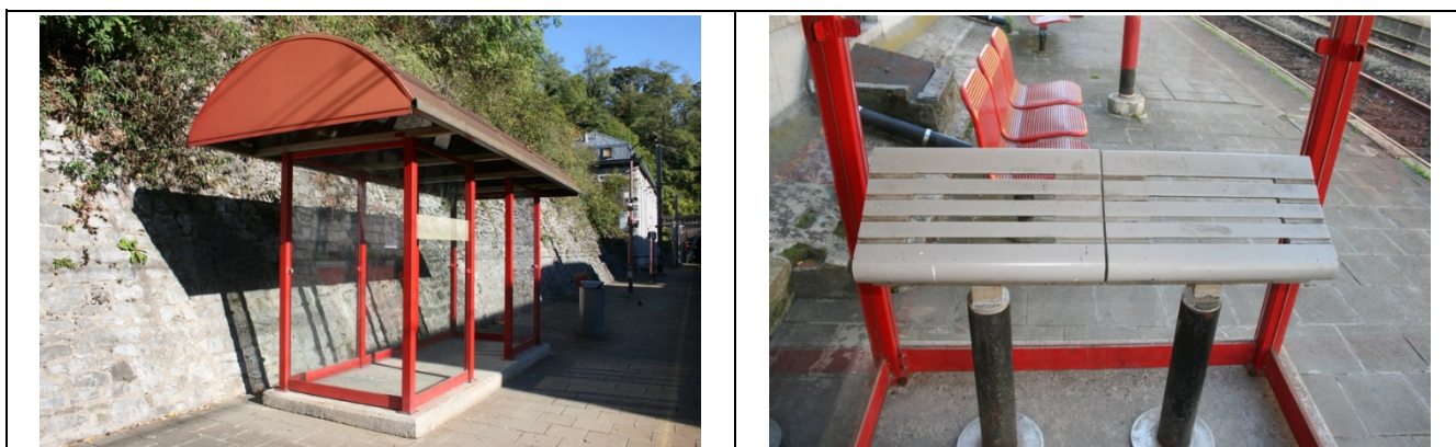
Abris sur les quais
