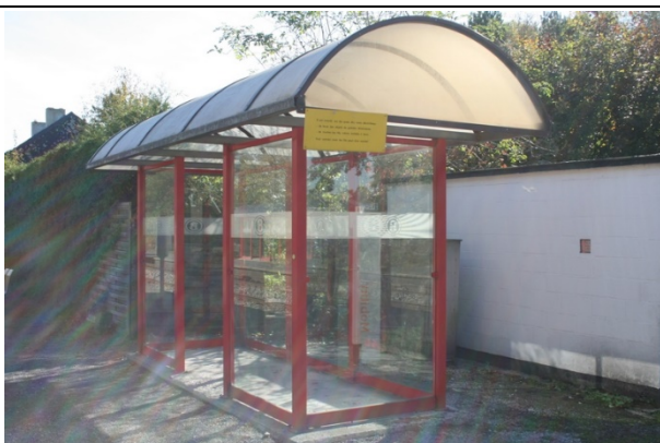
Abris sur les quais
