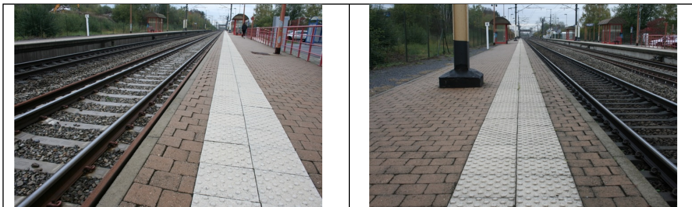
Revêtement des quais
