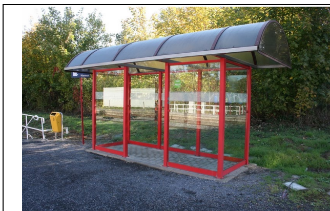
Abris sur les quais
