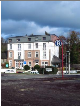
Accès pour voitures au niveau du totem SNCB rue Grande
