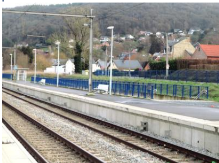
Les quais ont été réhaussés depuis notre dernière visite
