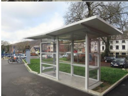
Nouvel abri de quai le long de la voie 1
