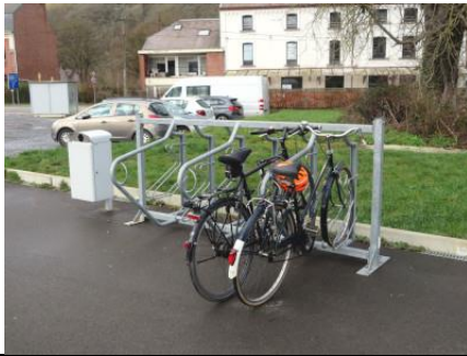
Râtelier pour vélos au niveau de la voie 1
