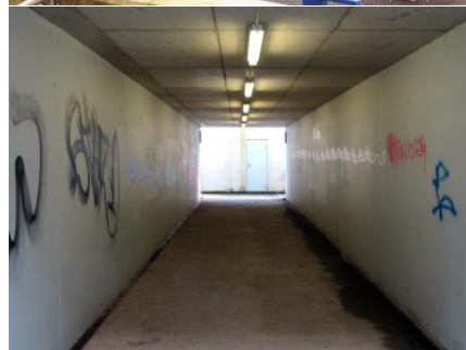
Intérieur du couloir sous voies
