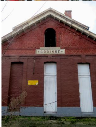
Façade latérale, côté Namur
