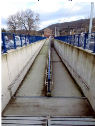
Rampe à pente douce donnant accès au couloir sous voies
