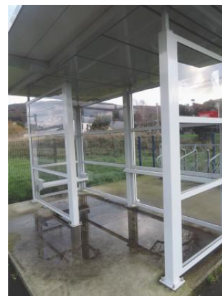
Abri de quai le long de la voie 2
