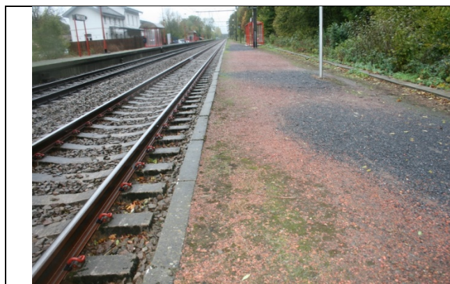
Revêtement des quais
