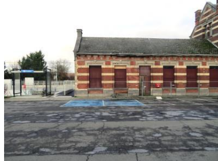
Deux places de parking PMR devant le bâtiment de gare
