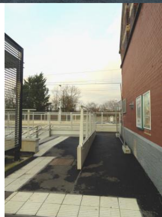
Accès au quai 1 (côté place de la Gare)
