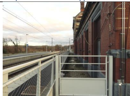
Le rehaussement des quais, la vente du bâtiment et le retrait de la marquise ont modifié l'apparence sur le quai 1
