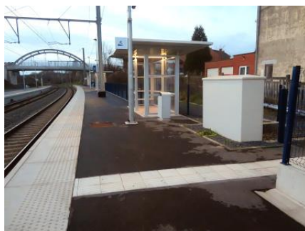
Dalles podotactiles indiquant l'accès au quai 2
