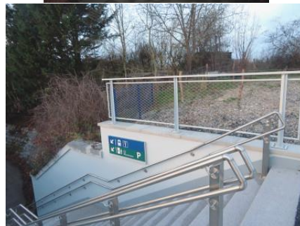
Escalier reliant le quai 2 au couloir sous voies
