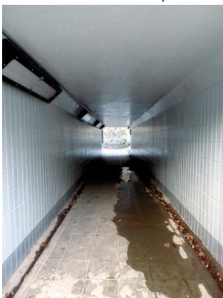
Le couloir sous voies
