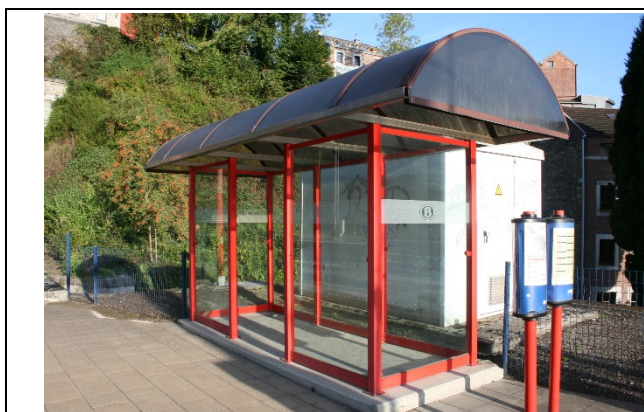
Abris sur les quais
