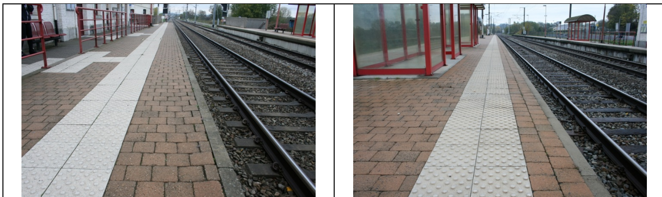
Revêtement des quais
