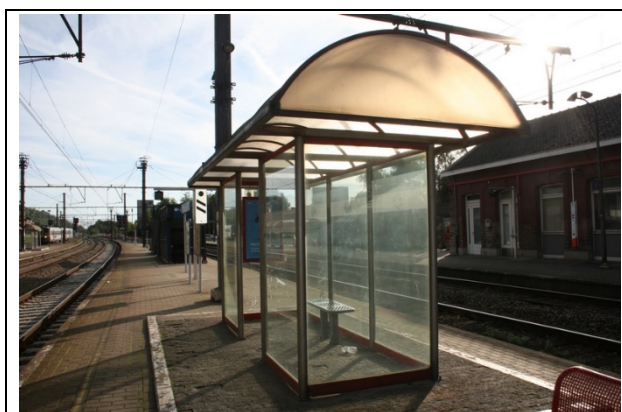
Abris sur les quais
