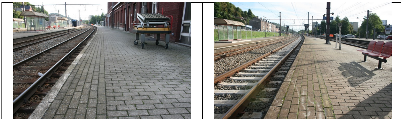
Revêtement des quais
