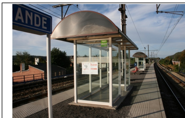
Abris sur les quais
