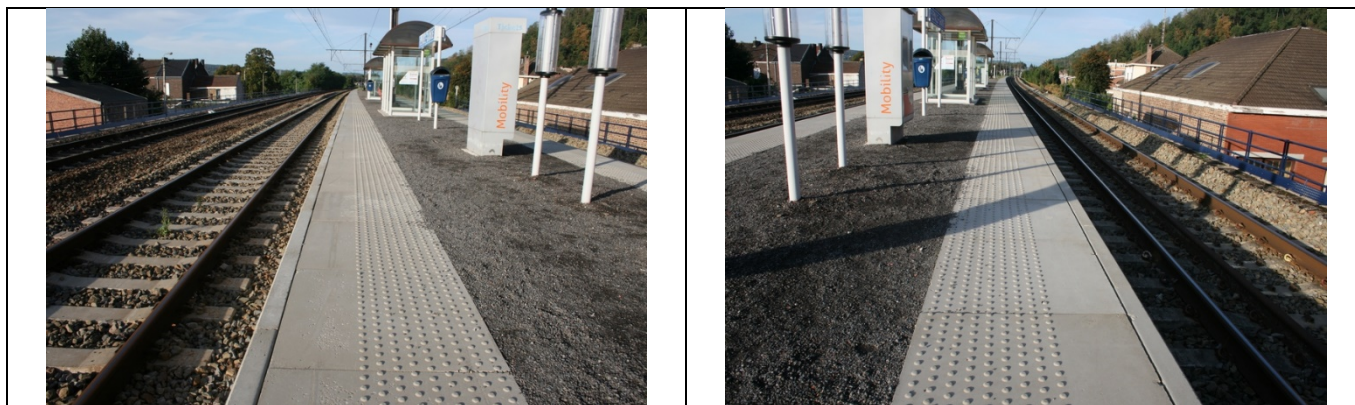
Revêtement des quais
