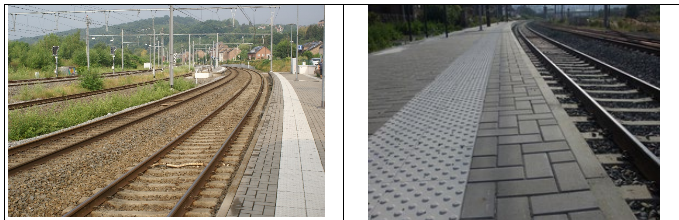
Revêtement des quais
