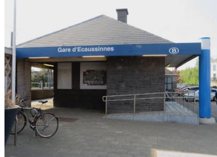
Abord de l'accès au quai de la voie 1
