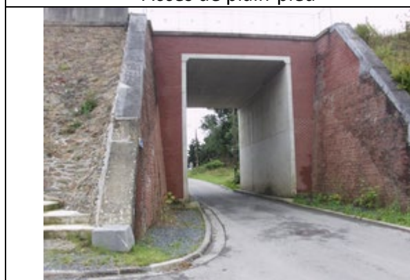
Pont sous les voies
