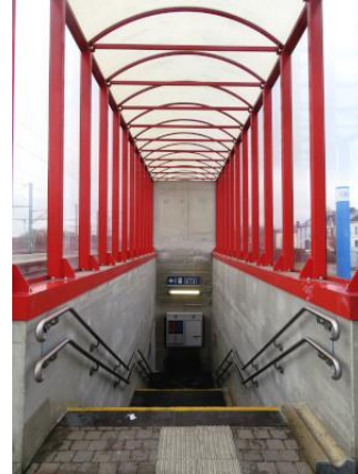
Entrée du couloir sous voies à partir du quai longeant le bâtiment
