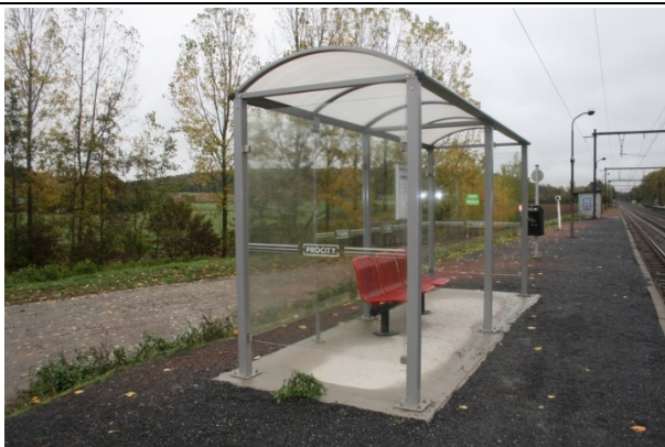
Abris sur les quais
