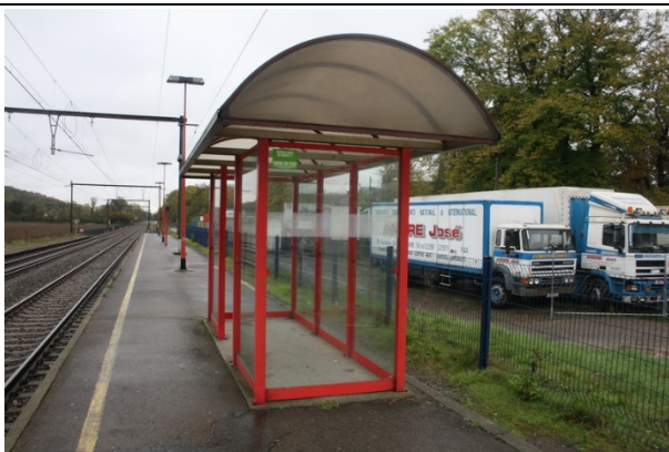
Abris sur les quais
