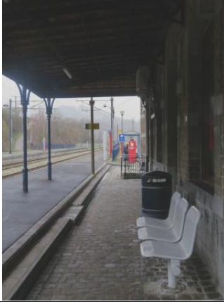
Trois places assises sous la marquise, à la voie 1
