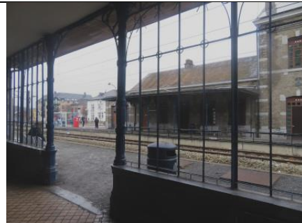
Le bâtiment vu de l'abri typique sur le quai opposé
