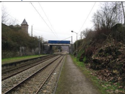
Voie 1 : vue du quai en montant de la rue Nicolas Lambercy
