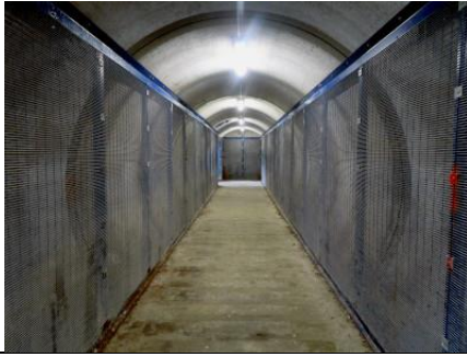
Le couloir sous voies de la gare d'Aywaille
