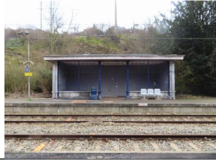
L'abri de quai typique de la ligne, voie 2
