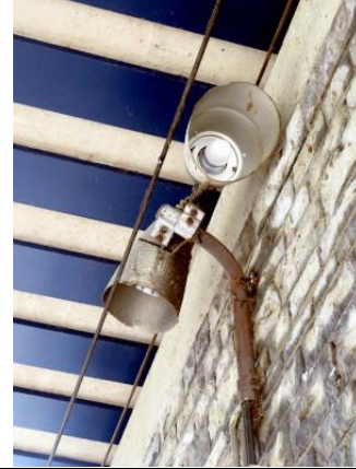
Toujours un éclairage au sodium, tel qu'posé ici sous la marquise du bâtiment
