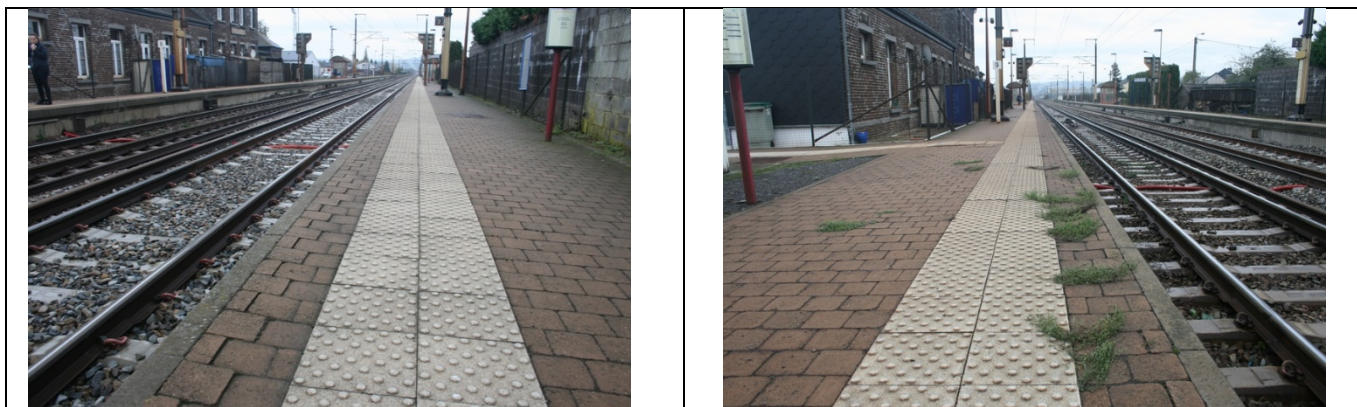
Revêtement des quais
