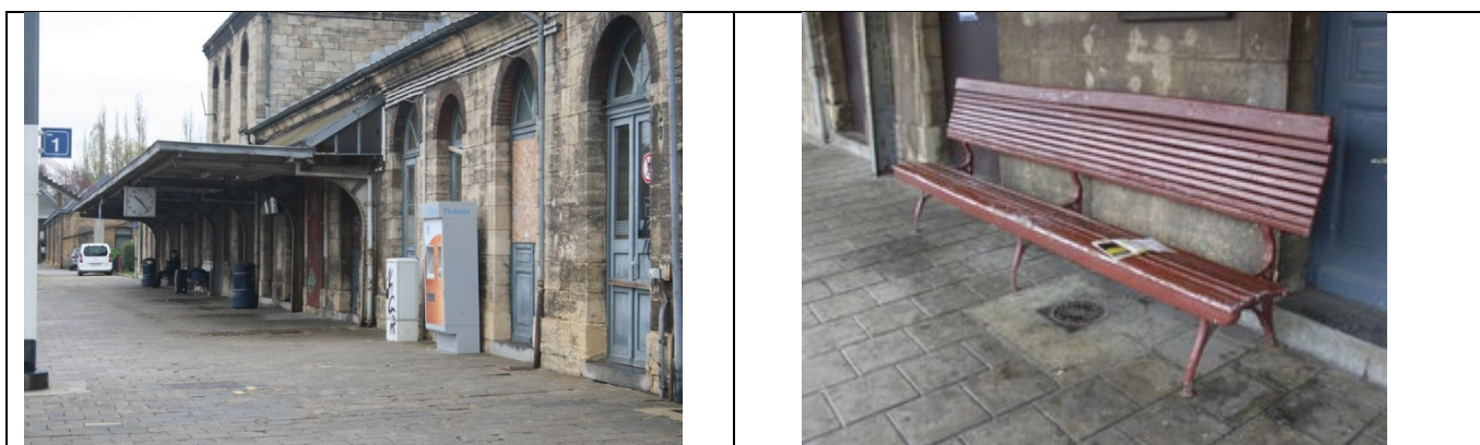
Quai partiellement couvert
