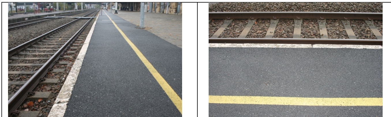
Revêtement des quais
