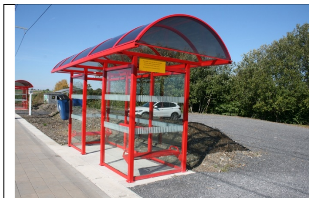
Abris sur les quais
